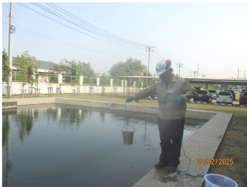
บ่อดำรงคุณภาพน้ำทิ้งก่อนระบายเข้าสู่ระบบบำบัดน้ำเสียส่วนกลางของ นิคมอุตสาหกรรมบางปะอิน
